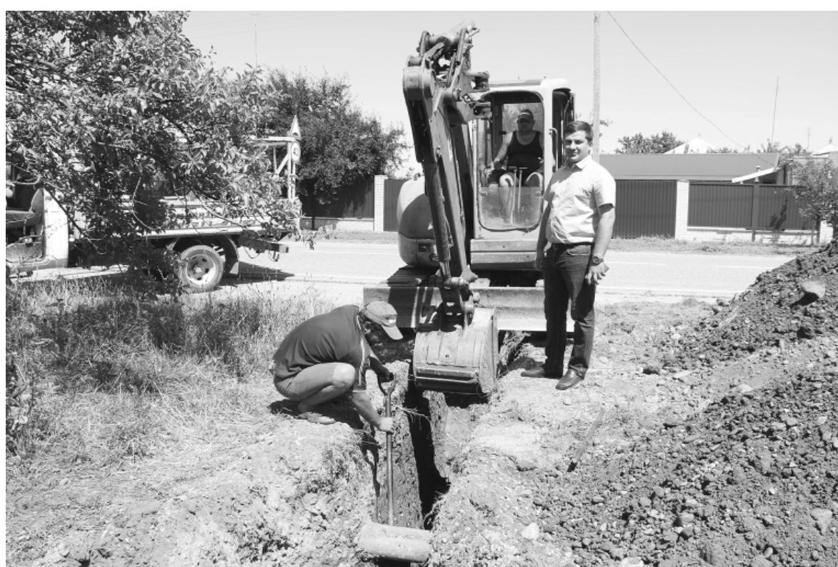
Что касается выполнения намеченных мероприятий, то уже в минувшем году была произведена реконструкция двух подземных газопроводов низкого давления общей протяженностью 350 метров – на территориях желез-
